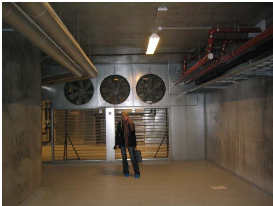
Figur 2. Kulvert nær inntak med spjeld og tilluftsvifter.
