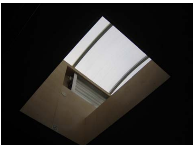
Figur 7. Spjeld for luftavkast i forbindelse med overlys.
