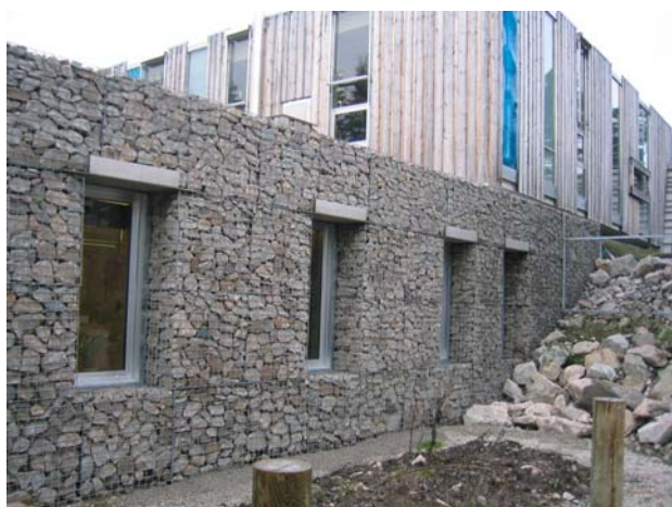
Figur 2. Yttervegger i 1. etg. med gabionforblending.
