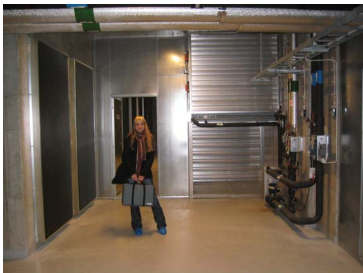
Figur 10. Gummipaneler i inntakskulvert (til venstre).
