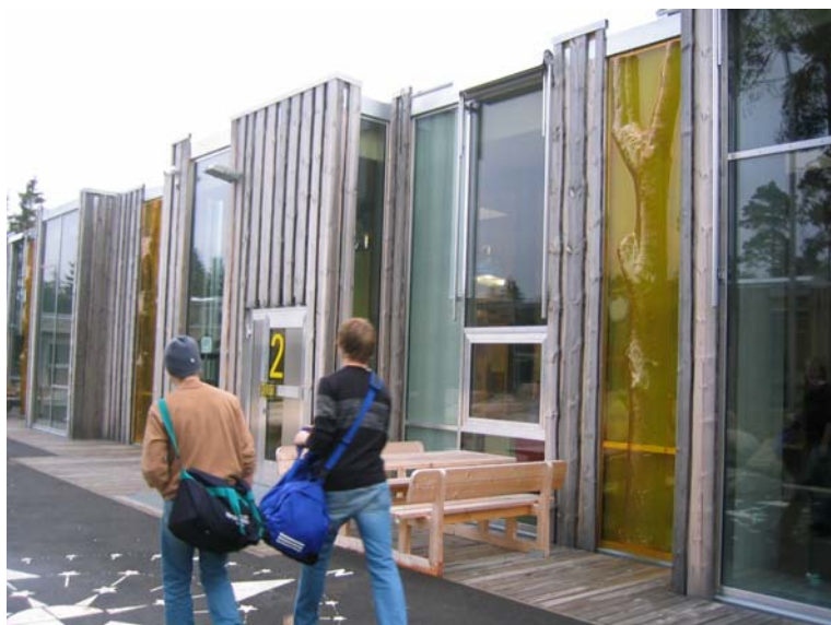
Figur 3. Yttervegger i 2. etg. med bindingsverk, glassfelt med isoflex (ser grå-blå ut på bildet), og glassfelt med plast-trær (gule felt).
