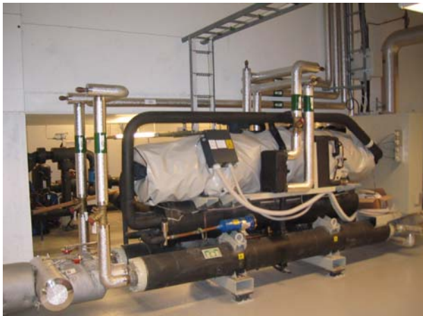
Figur 8. Varmepumpen.
