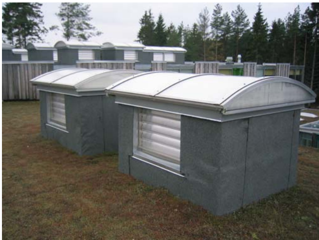
Figur 4. Overlys/luftavtrekk.
