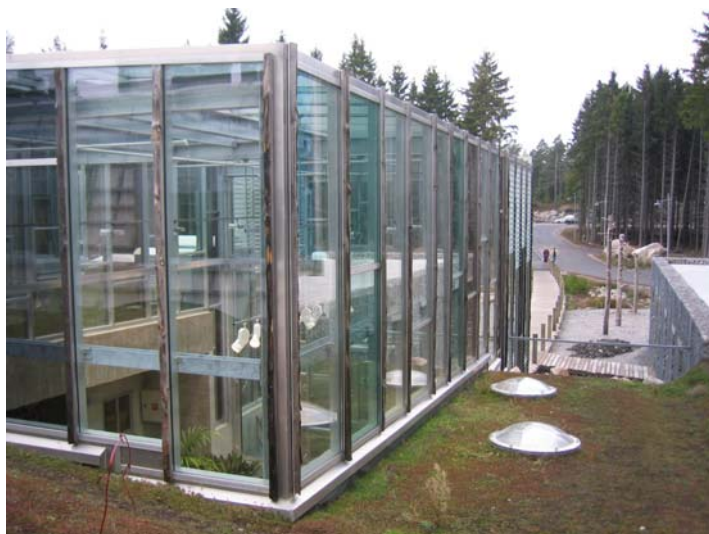
Figur 5. Luftinntak i forbindelse med inngangsparti.
